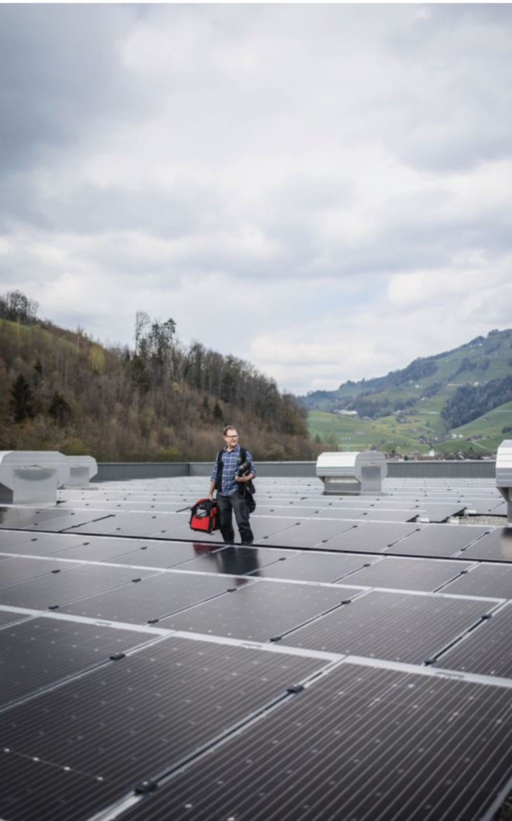
Daniel Ulrich prüft eine neu installierte Photovoltaikanlage im Schwyzer Talkessel.
